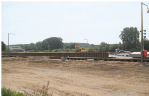
Abbildung 64: Wasserkraftwerk mit Staustufe in Dettelbach
