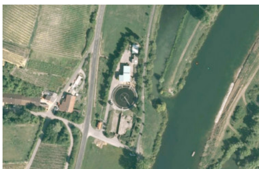
Abbildung 73: Kläranlage in Dettelbach aus der Luft
