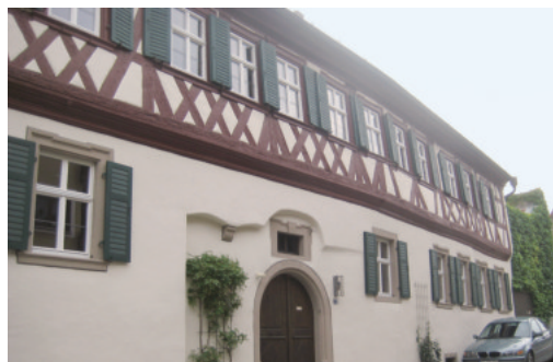
Abbildung 69: Sanierungsbeispiel in Dettelbach
