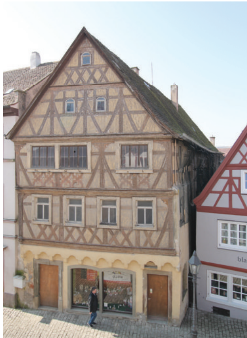
Abbildung 164: Gebäude Markt 7 („Götz-Haus“)
