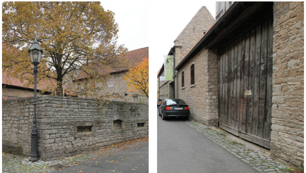
Abbildung 169: Beispiele für Abbruch / Integration von Stellplätzen, Dr.-Matthias-Horn-Straße, Stadt Dettelbach
